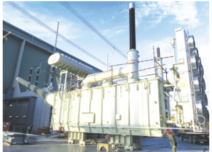
哈密—郑州±800 kV特高压直流输电工程哈密站 Transformer for Hami-Zhengzhou ±800 kV UHVDC transmission line
